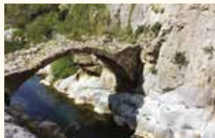
Pont de la Fou à Saint-Paul de Fenouillet
